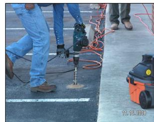
**Figura 3.** Muestra la perforación de agujeros para colocar tubos recolectores de gases del suelo, cerca del centro comercial Savings Square. (Fuente: EPA)
